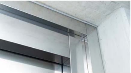
Panel mezi rámem dveří a stěnou
